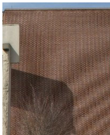
レンガの壁の写真を、不十分な周波数で標本化した結果モアレが生じた
